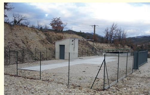
Sur l'aire collective de lavage des matériels de pulvérisation de la commune d'Aouste-sur-Sye, la gestion des eaux de pluie est assurée automatiquement par une électrovanne réglée sur l'ouverture du portail. Lorsque le portail s'ouvre, la vanne s'oriente vers le système de traitement.
